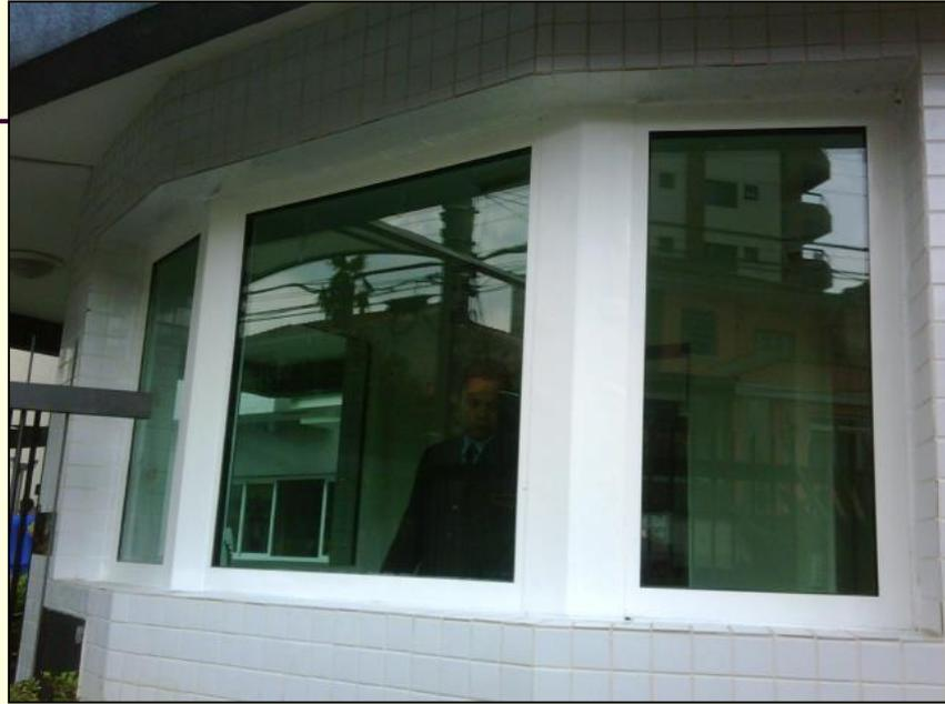
Os caixilhos blindados são fabricados com perfis de aço carbono soldados entre si através de solda MIG e revestidos com chapa dupla de aço carbono.
