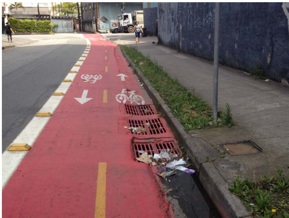
Utilização de sarjetas (área de drenagem)
