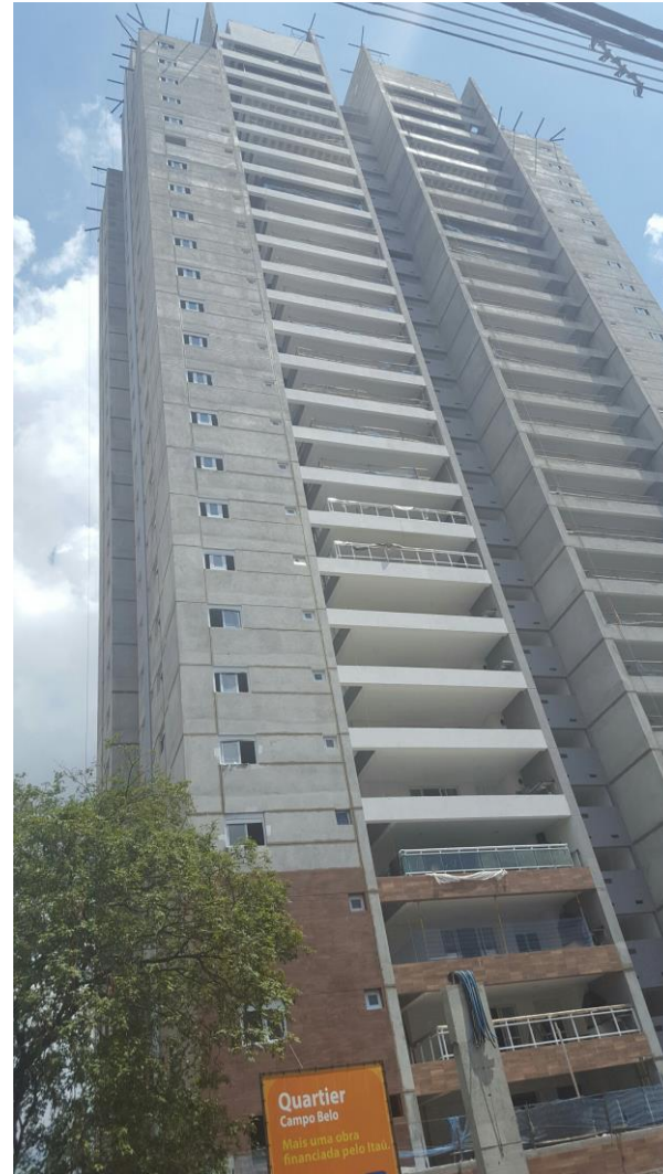
FOTO DA OBRA
