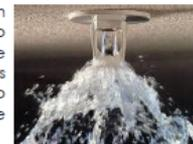
O sistema de sprinklers pode ser aplicado em edificações verticais, horizontais, comerciais, industriais, que necessitem de proteção automática e eficaz. Para o monitoramento da rede de sprinklers são instalados em determinados pontos estratégicos, chaves de fluxo para sinalização na central de alarme de incêndio, garantindo que o sistema seja supervisionado 24 horas por dia mediante sistemas eletrônicos de segurança de alta tecnologia.
