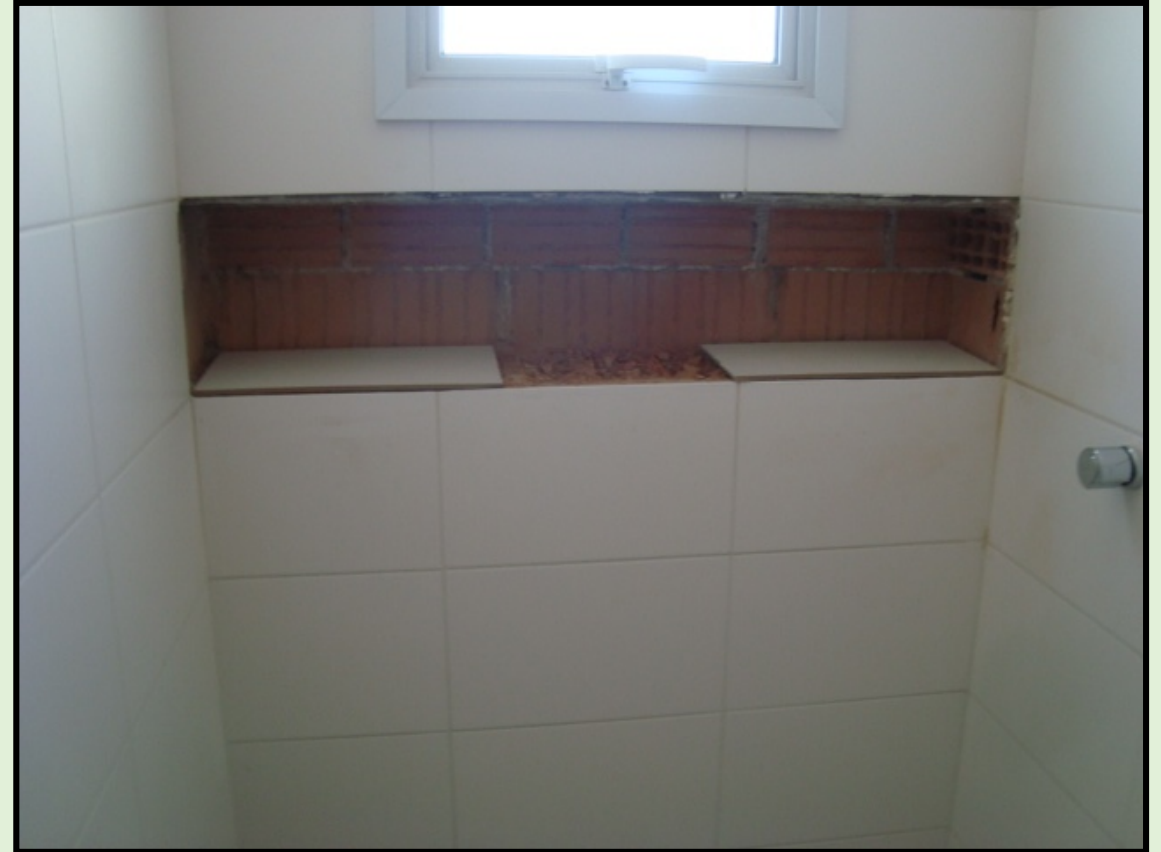
Nicho no box na parede da fachada
