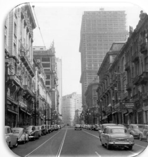
Ed. Conde Prates em construção
