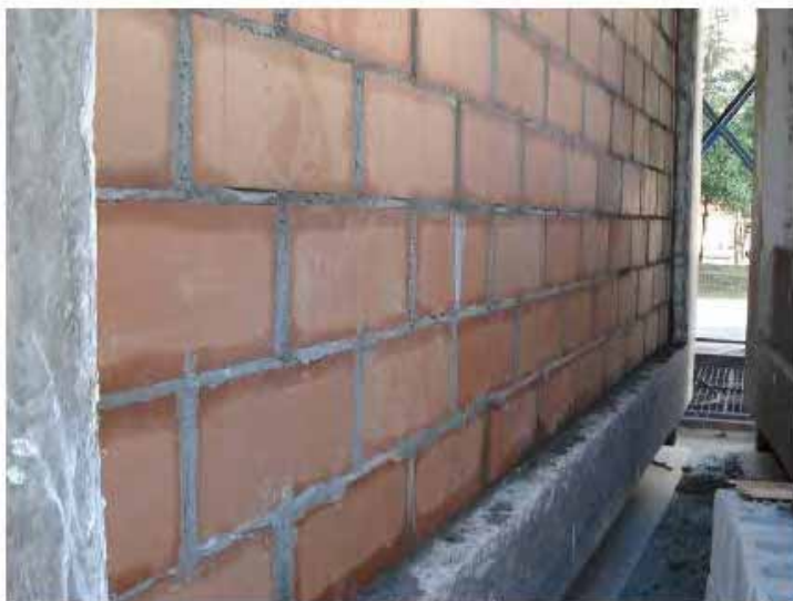
Figura 1 – Montagem da parede no pórtico do laboratório.
