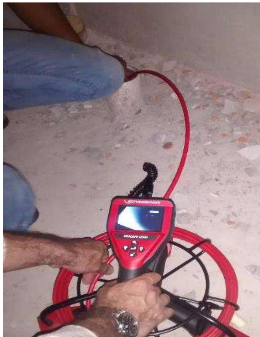
Filmagem de tubulação com boroscópio x Obstrução
