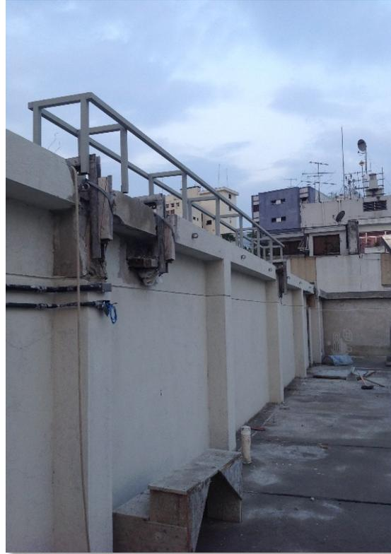
Estrutura metálica auxiliar para revestimento de fachada
