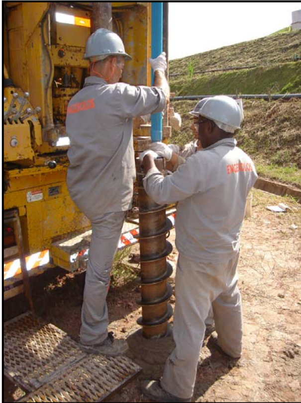
Instalação de poços de monitoramento
