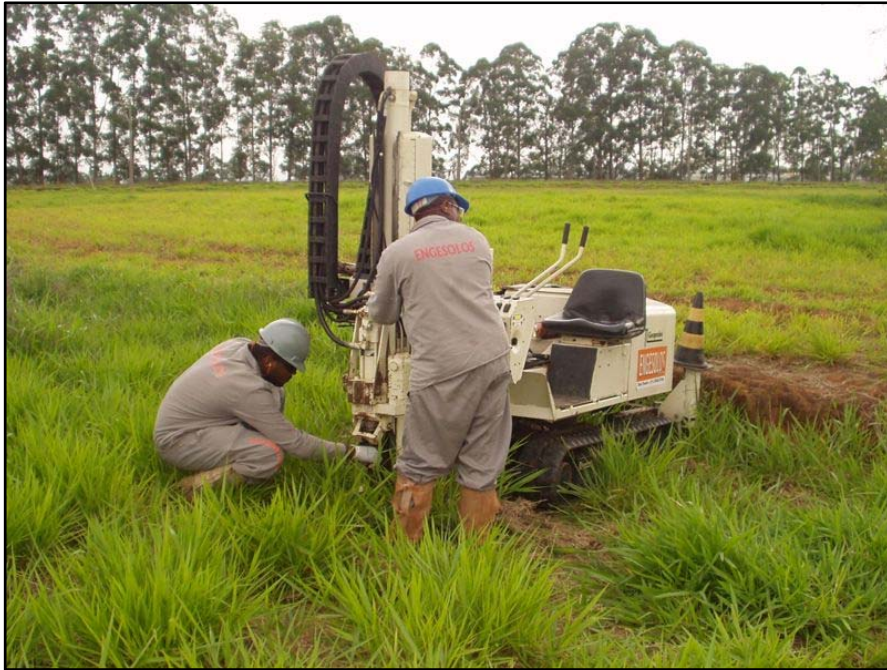
Execução de sondagens diretas
