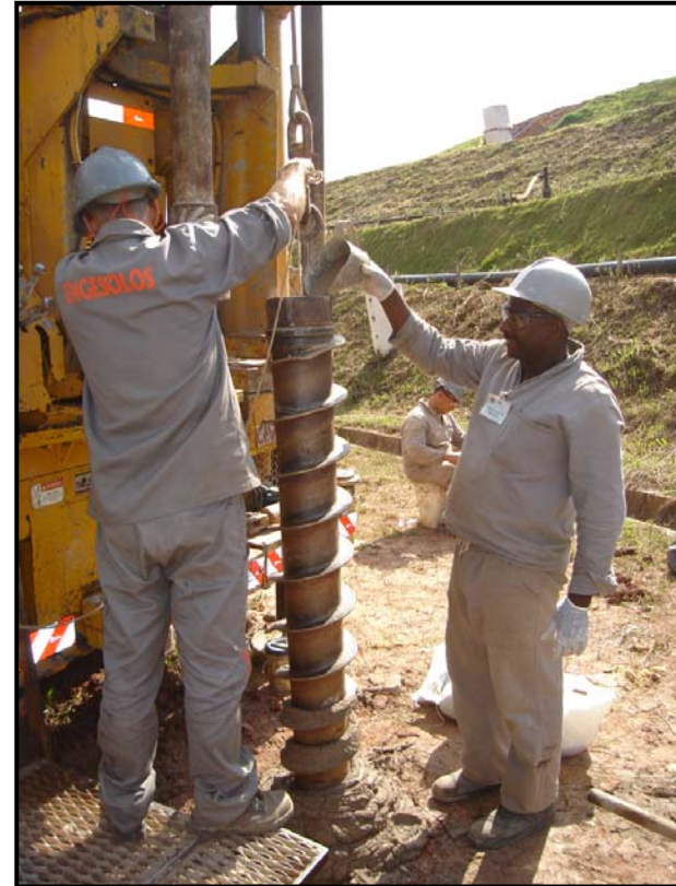
Instalação de poços de monitoramento
