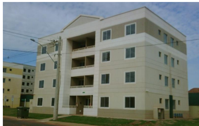
Foto da Obra
