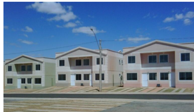
Foto da Obra
