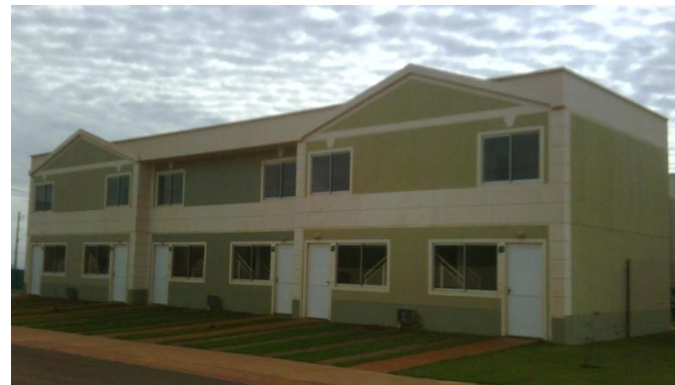
Foto da Obra
