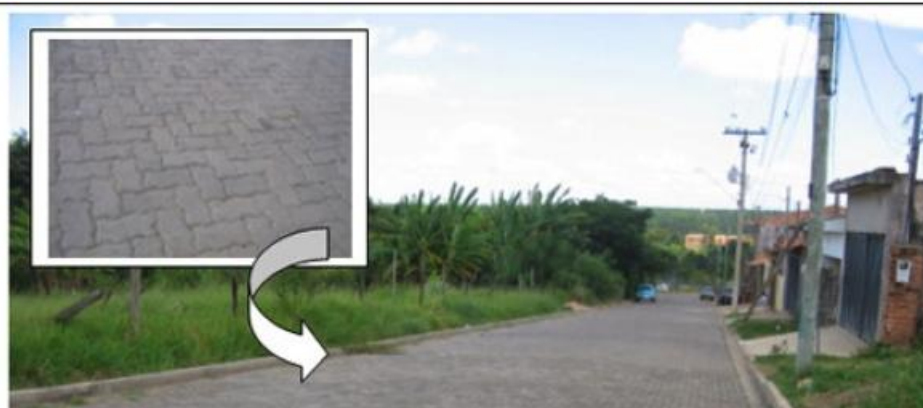
Pavimentação com pisos intertravados - composto de material reciclado
