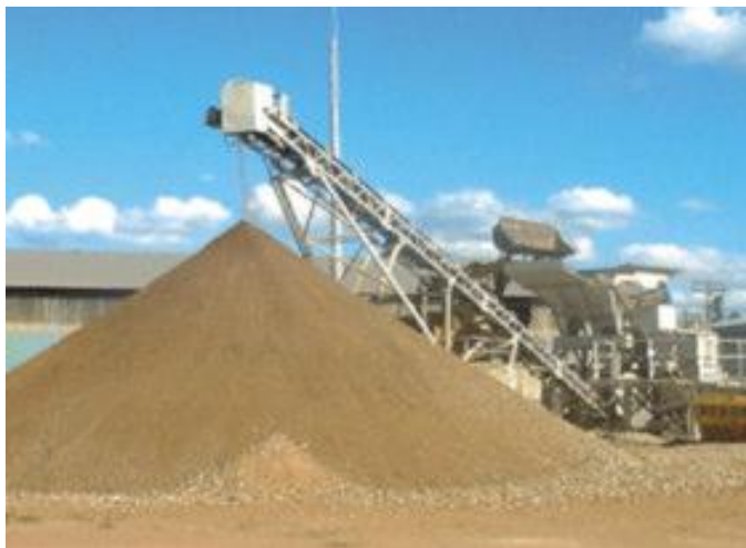
Usina de reciclagem
