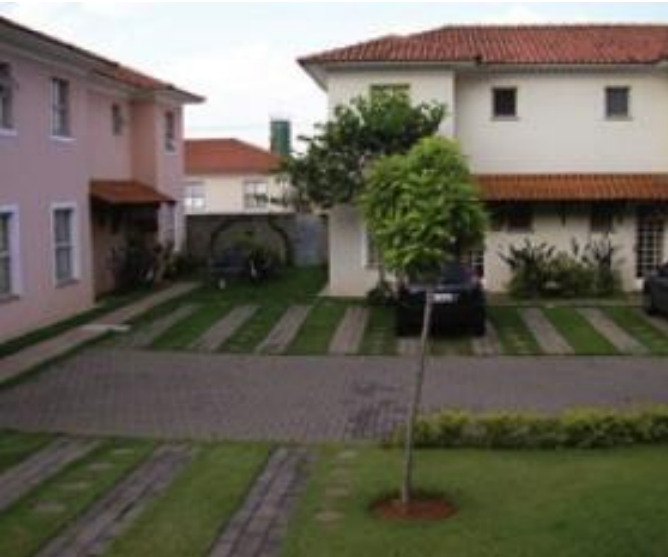
Estacionamento com a mescla de pavimentos permeáveis e não permeáveis
