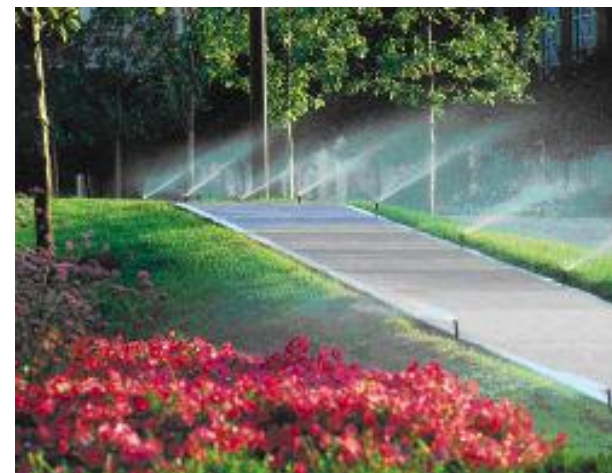
Sistema de aspersão: rotores
