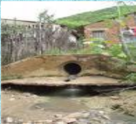
Coleta de Esgoto
