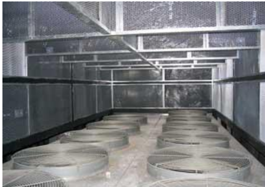
Simulação do tratamento Acústico / Área de Chillers - Condomínio Atrium V
