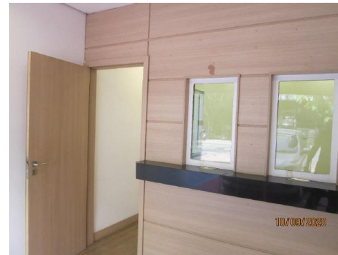
Cabine que foi instalada no salão principal.
